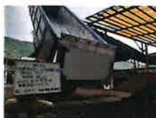
運搬した汚泥を処分業者 に荷下ろし中
